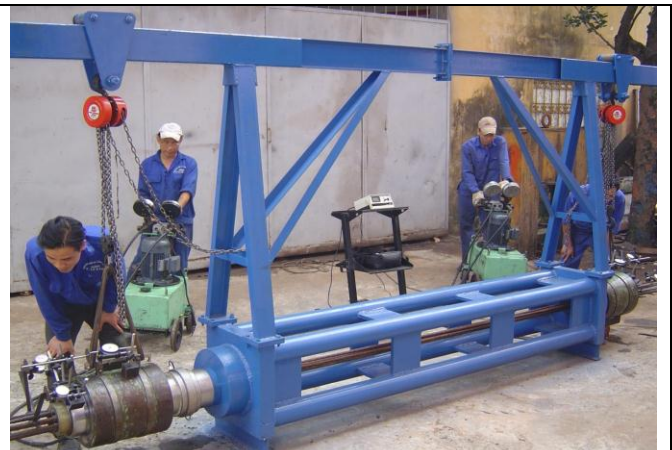
Căng kéo bó cáp - Kiểm tra đồng bộ hệ thống thiết bị căng kéo dự ứng lực
