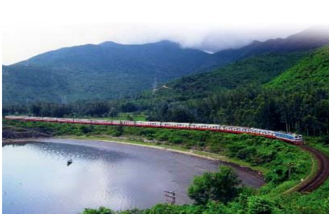
Lập báo cáo ĐTM, cho các dự án xây dựng cơ sở hạ tầng cho tuyến đường sắt Bắc Nam
