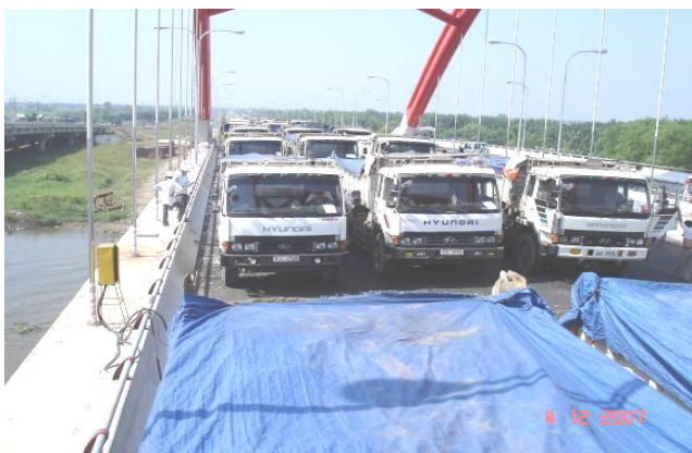
Kiểm định, thử tải Cầu Ông Lớn
