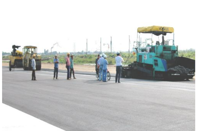
TVGS thi công bê tông nhựa polime đường hạ cất cánh Cảng hàng không Cần Thơ
